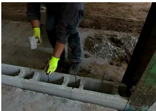
Instal·lació de barres metàl·liques de reforç
