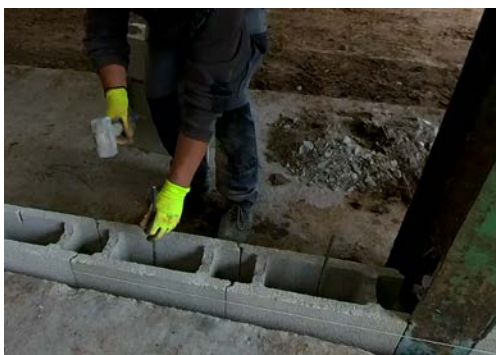
Instalación de barras de refuerzo metálicas.
